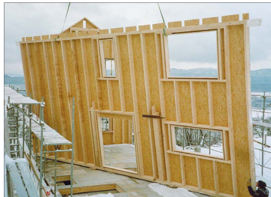
Der grosse Vorteil der Holzelement-Bauweise von Fecker Holzbau liegt neben dem ökologischen Aspekt auch im behaglichen Wohngefühl.
